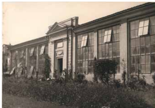
Facciata dell'edificio delle serre, 1956. Parma, Archivio dell'Orto Botanico.
